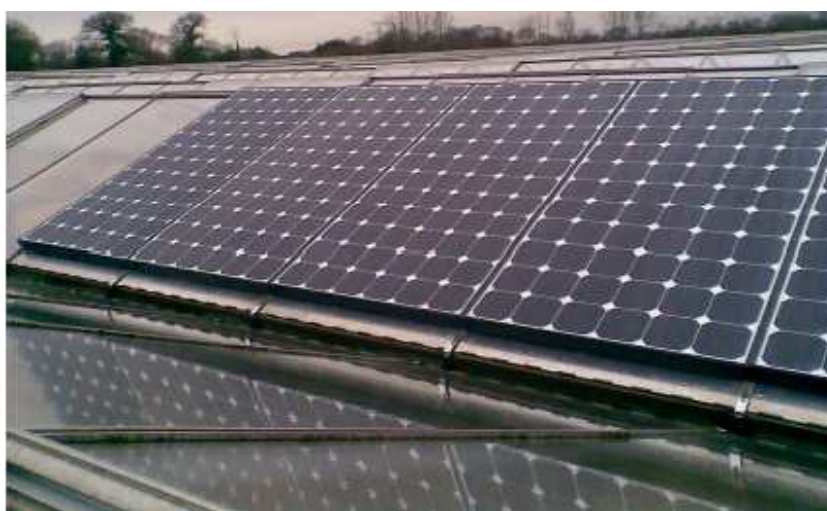
Photographie 2. Exemple de panneaux solaires sur serre Venlo (avec en pied de panneau, le profil d'étanchéité - photo : Mat Energie Consult).
