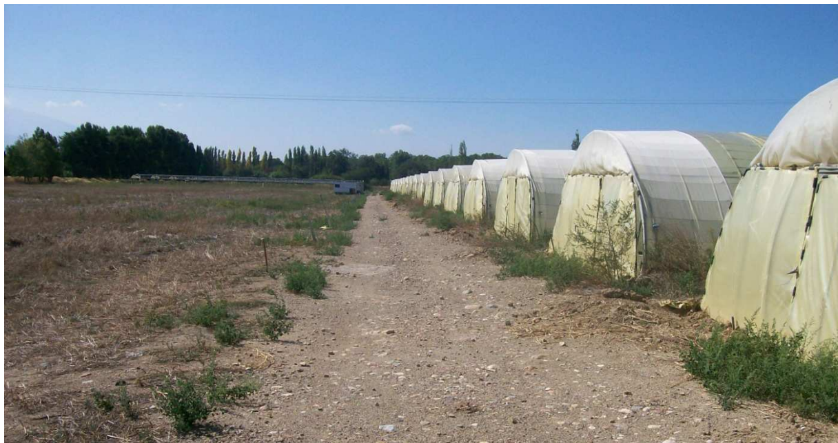
Photographie 1 : à gauche, parcelle OB525 en friche (broyée), à droite les serres couvertes, au fond les structures de serres abandonnées
